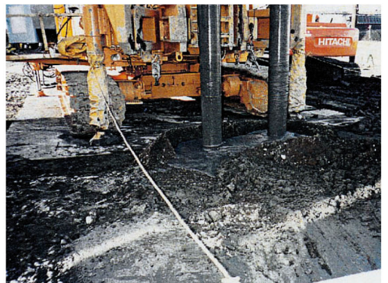
固化体打設状況
