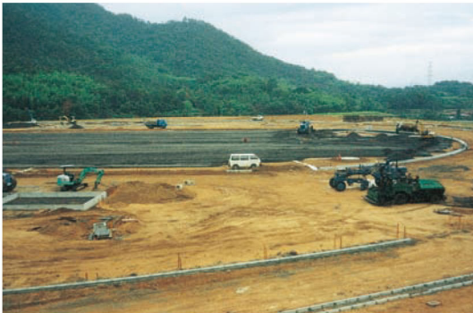
グラウンド地盤改良例
