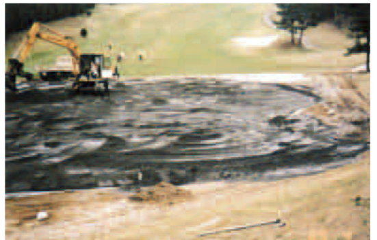
ゴルフ場地盤改良例
