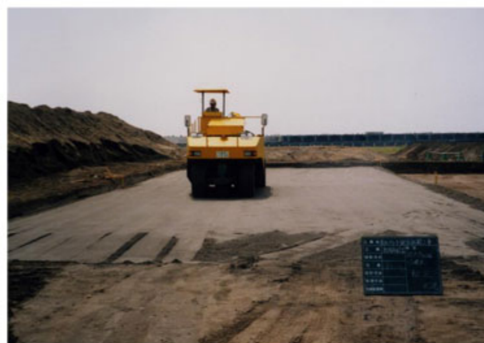
凍上抑制層施工
