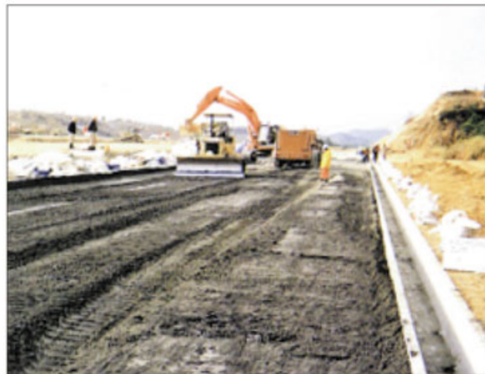
下層路盤施工
